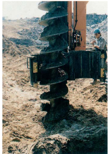
Endlosschnecke 600 mm Durchmesser im Einsatz Vis sans fin de 600 mm de dia en service Continuous flight auger 600 mm dia. during operation
